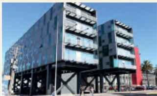
Este edificio de oficinas en Concepción está construido a 10 metros del suelo para enfrentar el peligro de los tsunamis.
