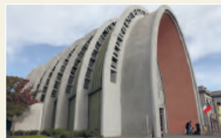
Esta iglesia fue destruida por el terremoto de Chillán (1939). Se reconstruyó con una estructura antisísmica y resistió el terremoto de 2010 con daños estructurales menores.
